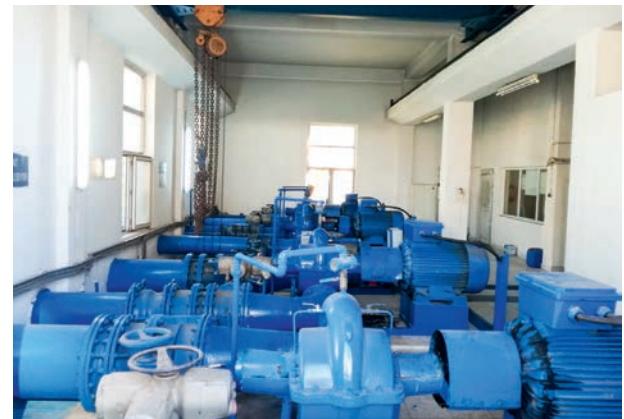
Çağlayan Terfi Merkezi
