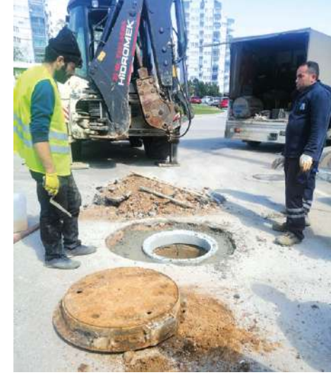
2022 Yılında Merkez ilçelerde 12.840 adet kanalizasyon kapağı asfalt ve kaldırım Kotuna getirilmiştir.
