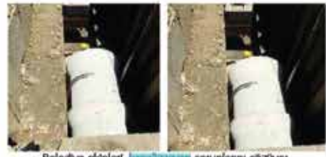
Belediye ekipleri, kanalizasyon sorunlarını çözüyor.
