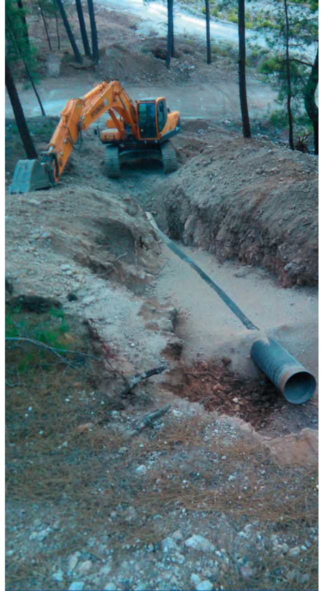
Kumluca Muhtelif Mahalleleri İçmesuyu İnşaatı Yapım İşİ
