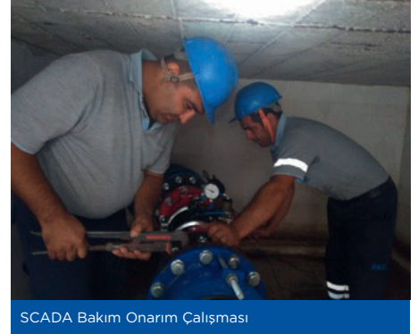
SCADA Bakım Onarım Çalışması
