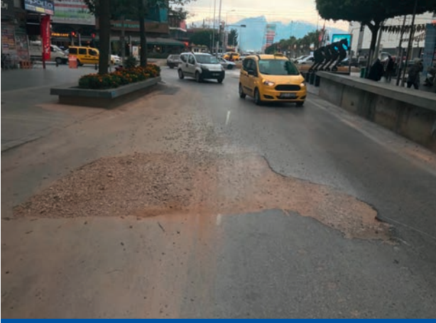
Sıcak Asfalt Dökümü Öncesi
