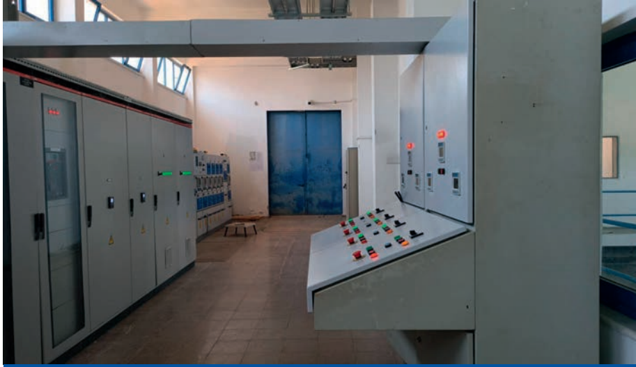
Duraliier-2 Yataay Santrifüj Motor Panoları
