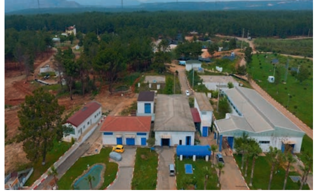
Duraliler Su Üretim Tesisi
