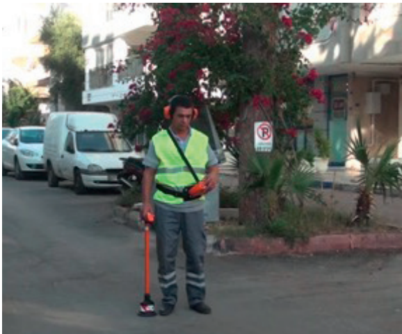
Fiziki Kaçak Tespit Çalışması
