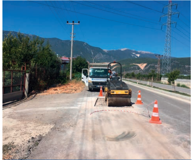
Sıcak Asfalt Dökümü
