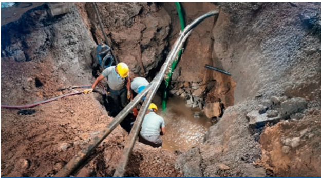
İçme Suyu Hattı Arızası Onarımı
