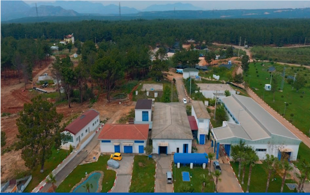
Duraliler Su Üretim Tesisi
