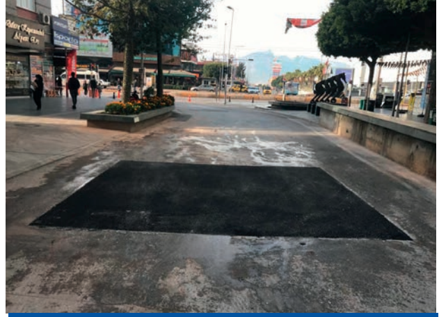
Sıcak Asfalt Dökümü Sonrası
