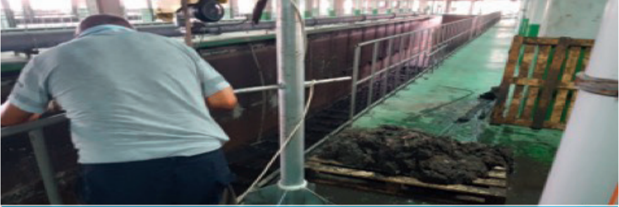
Havalandırma Havuzu Dip Temizlikleri
