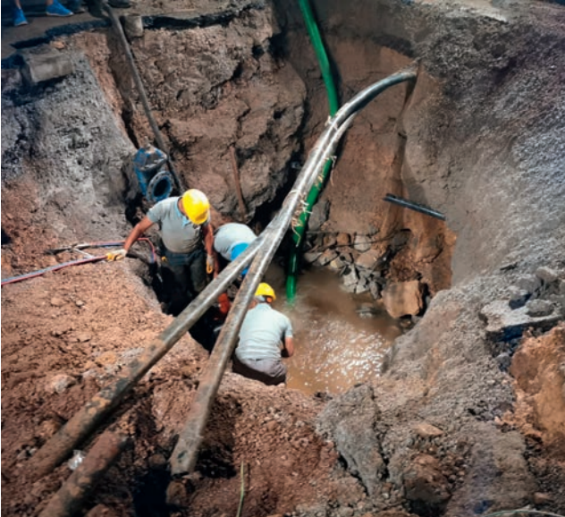
İçme Suyu Hattı Arızası Onarımı
