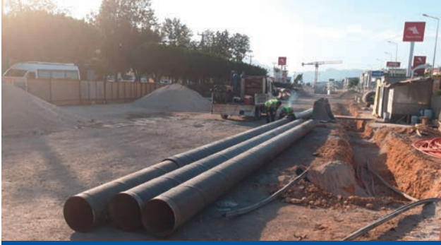
DSİ Kavşağı Deplase Gündüz Çalışması
