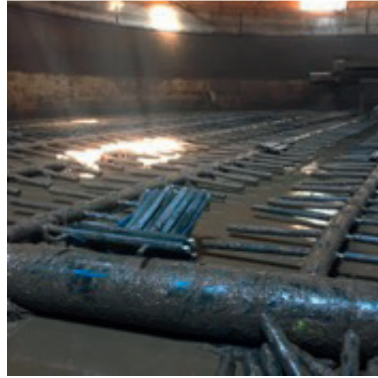
Difüzör Değişimleri
