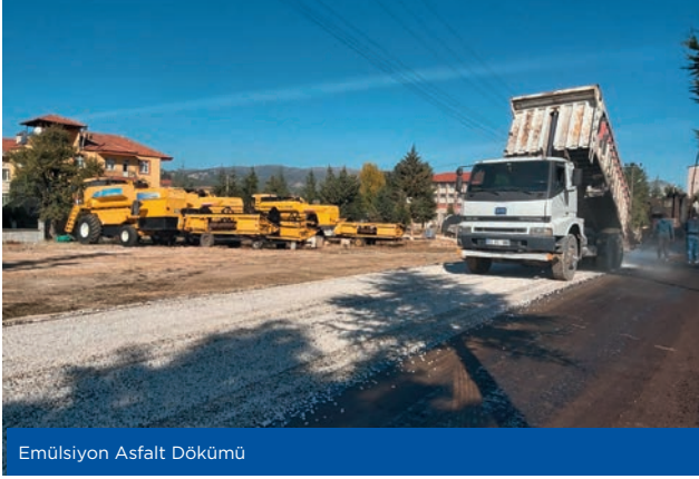
Emülsiyon Asfalt Dökümü
