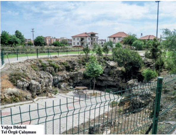
Bıyıklı Düdeni Tel Örgü & Uyarı Levhası Çalışması
