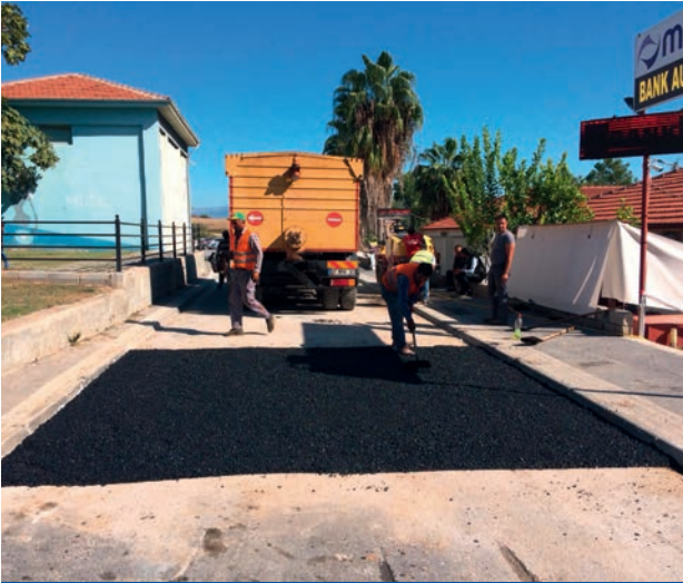
Sıcak Asfalt Dökümü
