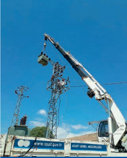
Trafo Montaj Çalışması
