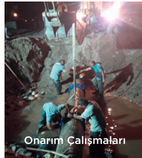
Asbes Boru Terfi Hattı Patlağı
