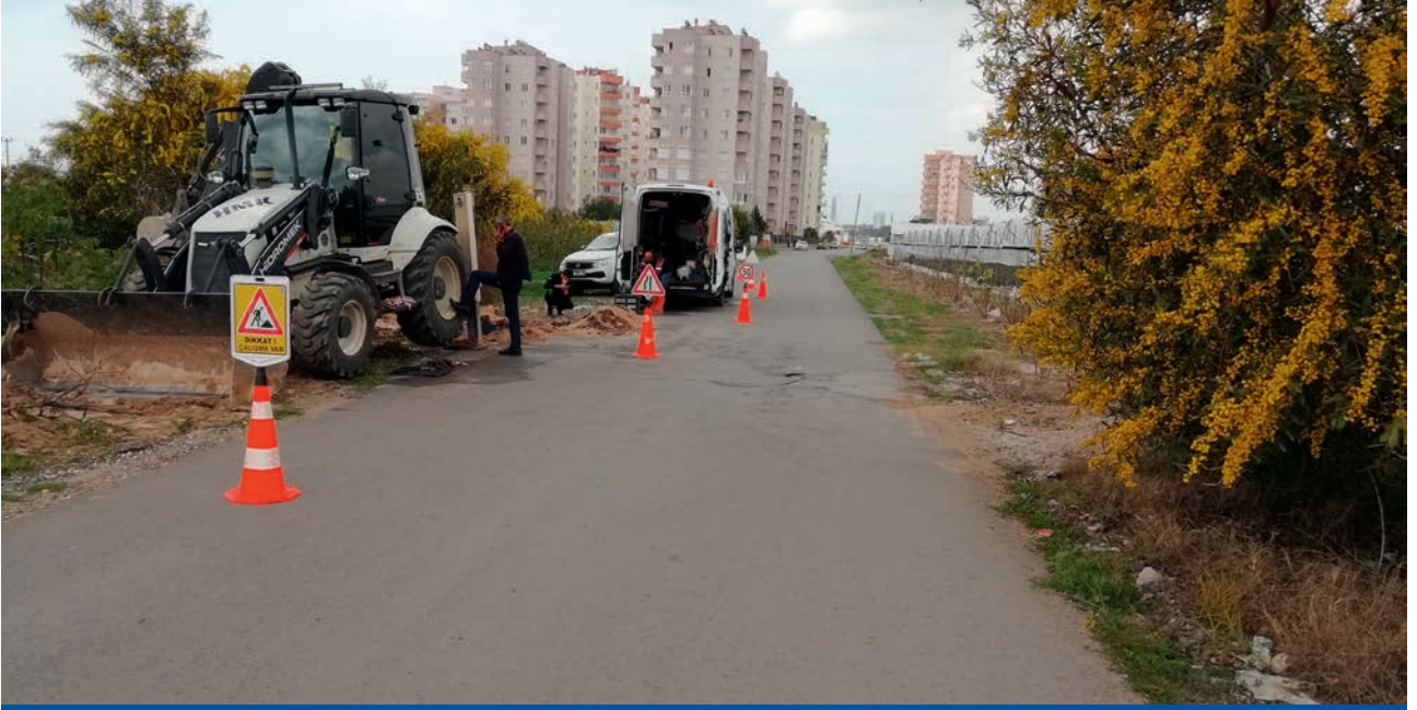
İçme Suyu Arızası Onarımı
