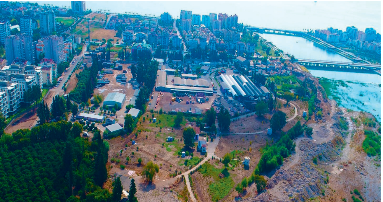
Boğaçay Pompa İstasyonu
