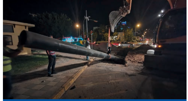
DSİ Kavşağı Deplase Gece Çalışması
