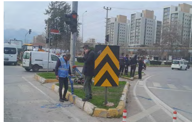
Planlanan köprülülük kavşak çalışmaları için isale hattı (Ø 1000 mm) yeri tespit çalışmaları
