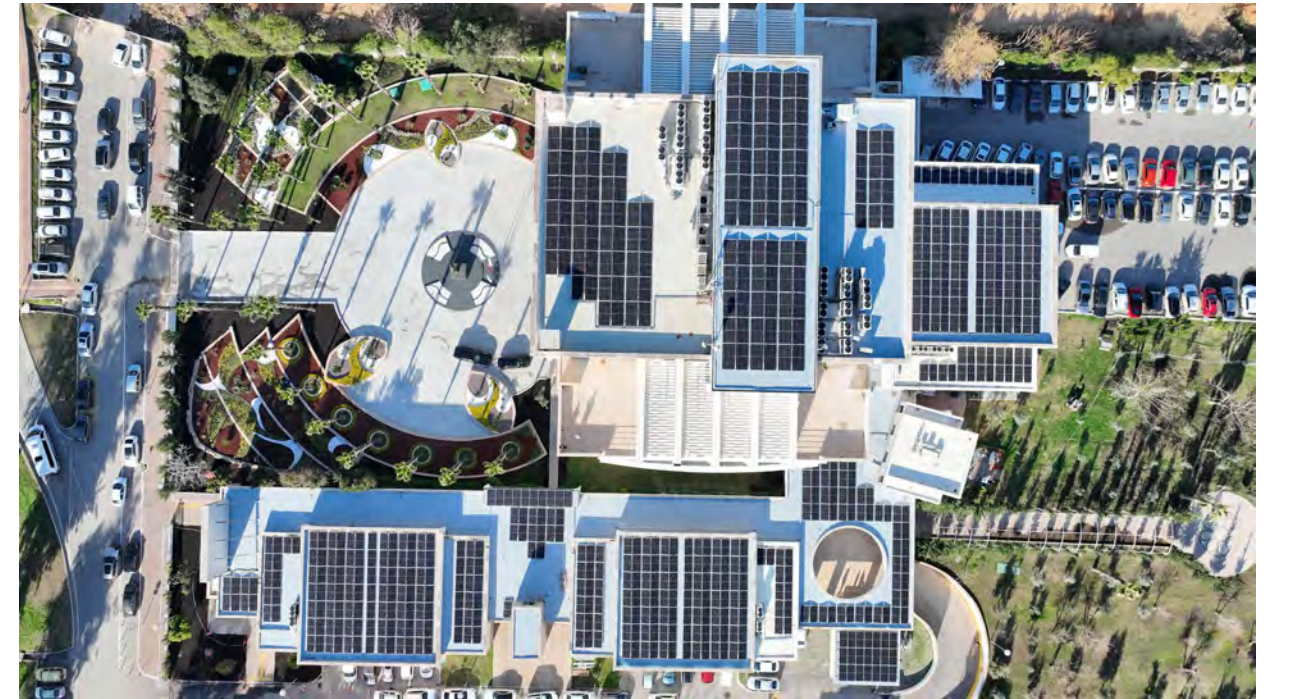
ASAT Genel Müdürlüğü Çatı GES (0,341 MWp)
