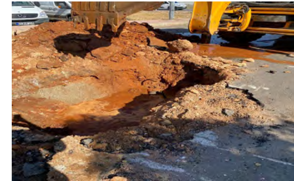
Kepez İlçesi, Atatürk Mahallesi 2627. Sokak Su Arıza Bakım Onarım Çalışması
