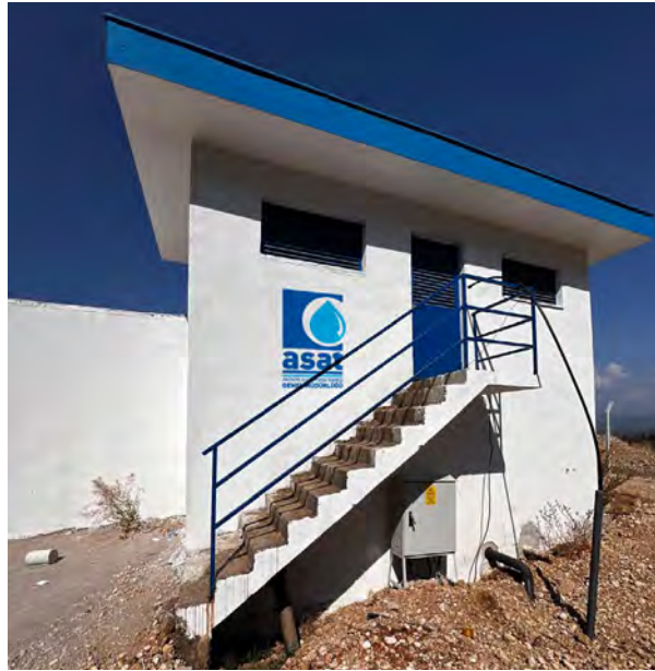
Aksu Alaylı 250 m³ içmesuyu Deposu
