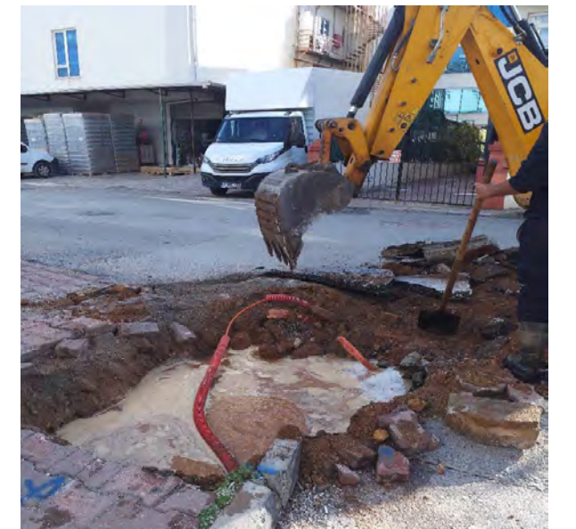
Muratpaşa İlçesi, Muratpaşa Mahallesi 598. Sokak Fizikî Kaçak Arama Su Arıza Bakım Onarım Çalışması
