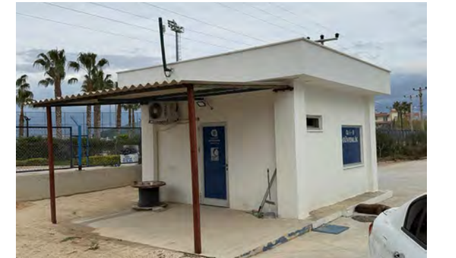
EMİNCELER SU ARIZA VE MALZEME DEPOSU GÜVENLİK OFİSİ
