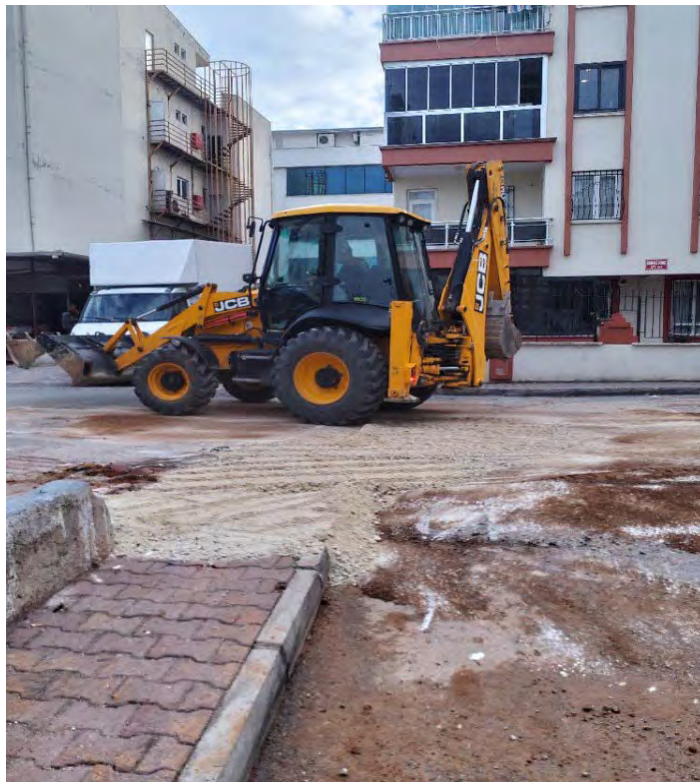
Muratpaşa İlçesi, Muratpaşa Mahallesi 598. Sokak Fiziki Kaçak Arama Su Arıza Bakım Onarım Çalışması
