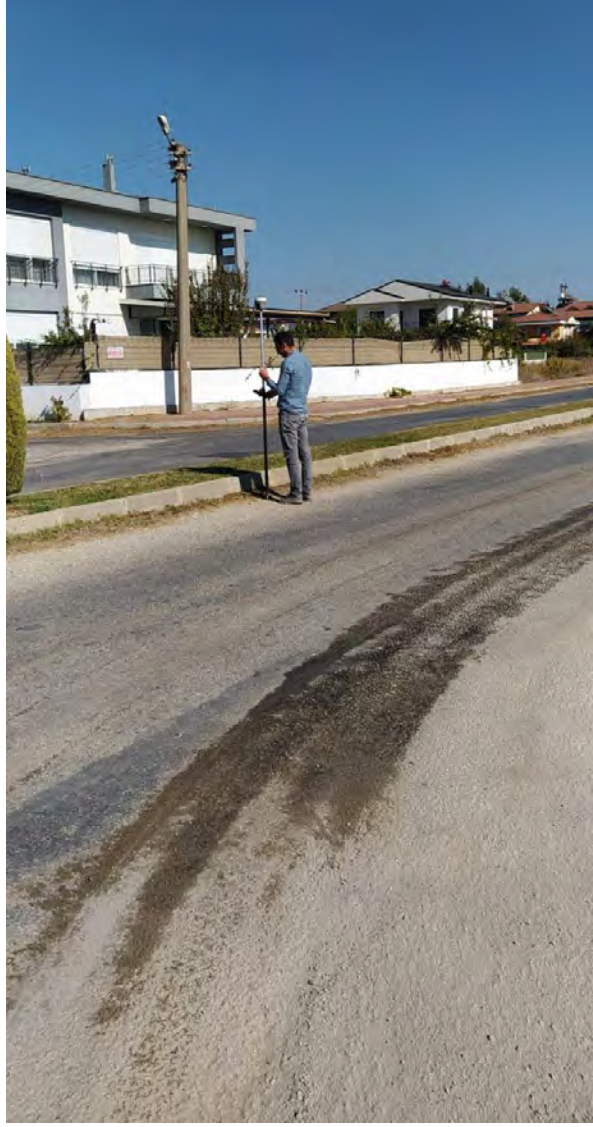
Manavgat-Sorgun kanalizasyon hattı arazi ölçümü
