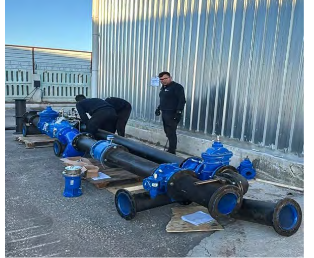
Şekil 70. Bağımsız Alt Bölge (DMA) Giriş Menholü Borulama Mekanik Uygulama Çalışması
