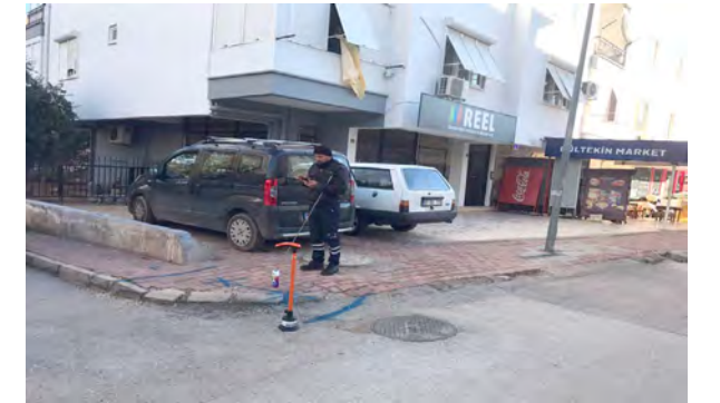
Muratpaşa İlçesi, Muratpaşa Mahallesi 598. Sokak Fizikî Kaçak Arama çalışması
