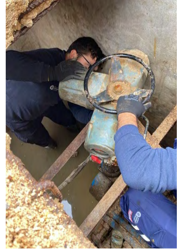
Boğaçayı Tesisinde Hat anası Bakım ve Tamirâtı
