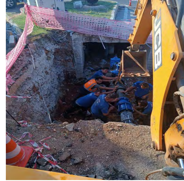
DMA Enstrümanları Montajı
