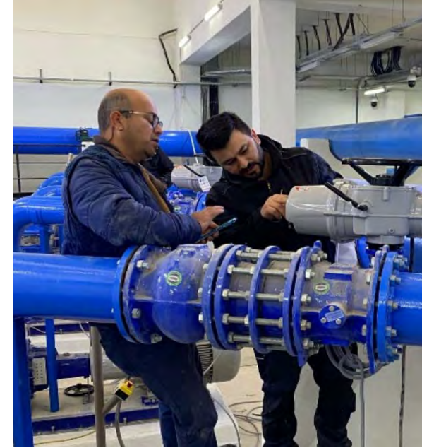
Belek Depo 4 te bulunan actuatörlerin montajı
