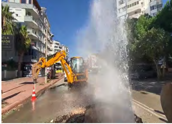
Konyaaltı İlçesi, Liman Mahallesi, 3079 Bileydiler Caddesi Ø110mm PE arıza tespiti.
