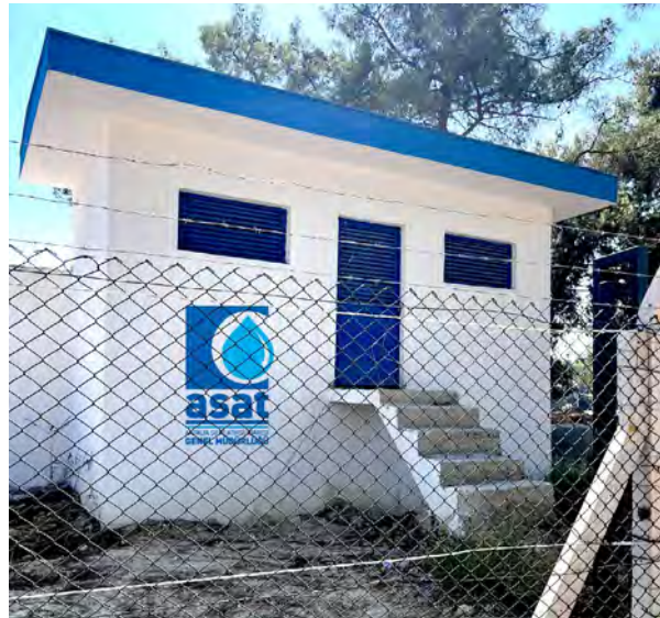
Aksu Güllük 250 m³ içmesuyu Deposu
