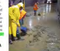
larda ve kaldırımlarda onarım yapıyor.
