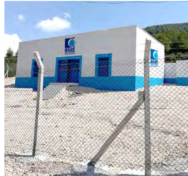
Döşemealtı Dağbeli 1.000 m³ içmesuyu Deposu
