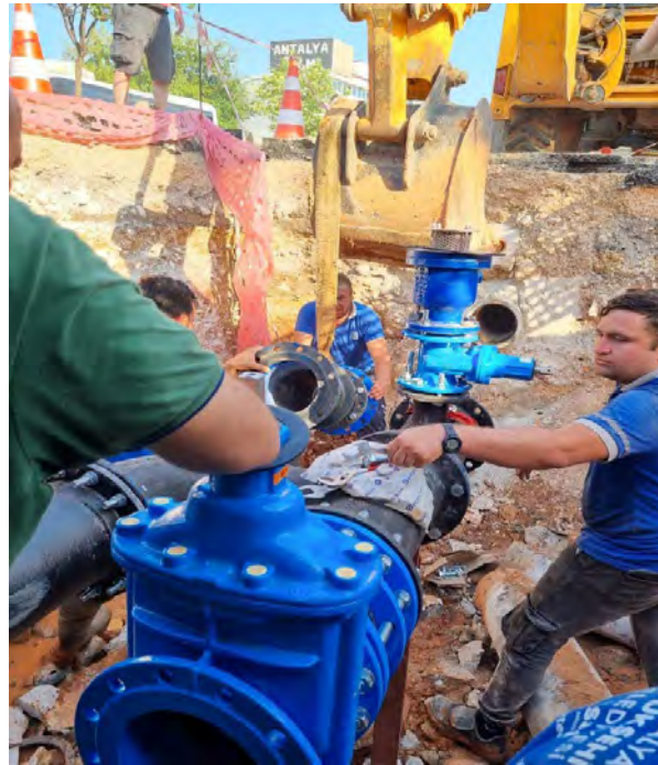
DMA Menhollerinde bulunan enstrümanları montajı
