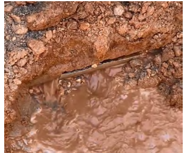
Kepez İlçesi, Kuzeyyaka Mahallesi, Şelale Caddesi Ø100mm ACB boru arıza tespiti.
