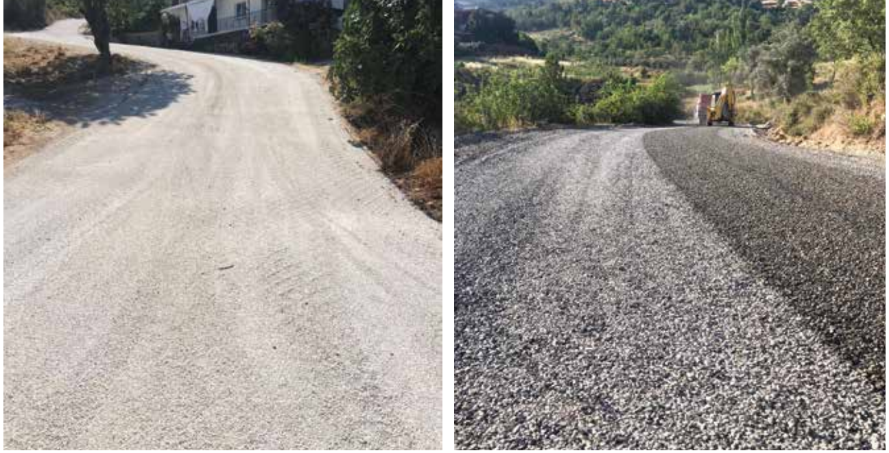
Emülsiyon Asfalt Dökümü
