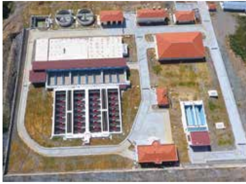
İÇME SUYU ARITMA TESİSİ
