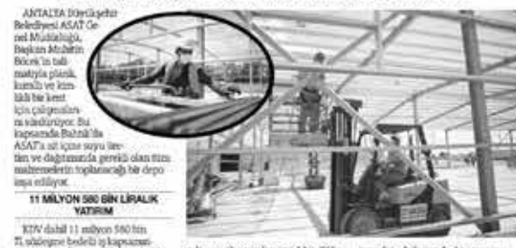
ASAT Genel Müdürlüğü Bahtılı'da yeni depo yapıyor. 7 bin 662 metrekarelik alana inşa edilmekte olan depoda tüm Antalya'nın içme suyu malzemeleri depolanacak.
