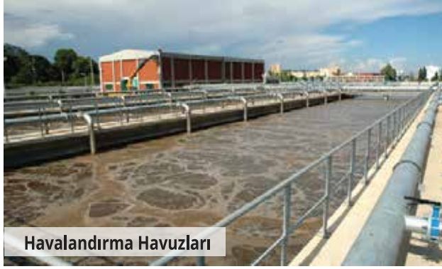
Lara AAT Scada Sistemi
