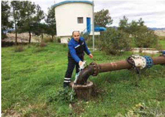
İçme ve Kullanma Suyu Sondajlarından Numune Alımı
