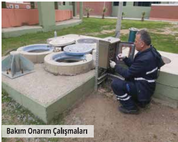
Bakım Onarım Çalışmaları
