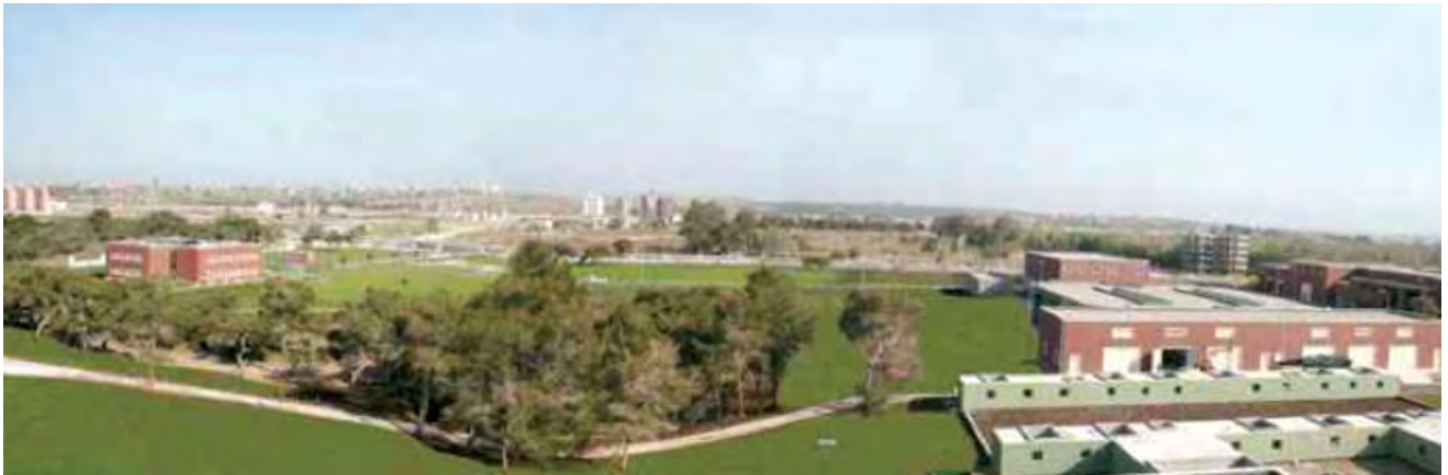
Lara İleri Biyolojik Atıksu Arıtma Tesisi/Genel Görünüm
