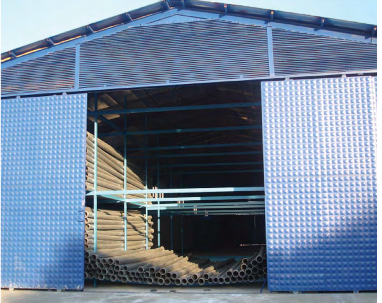
YENİ MALZEME AMBARI DIŞ GÖRÜNÜŞ
