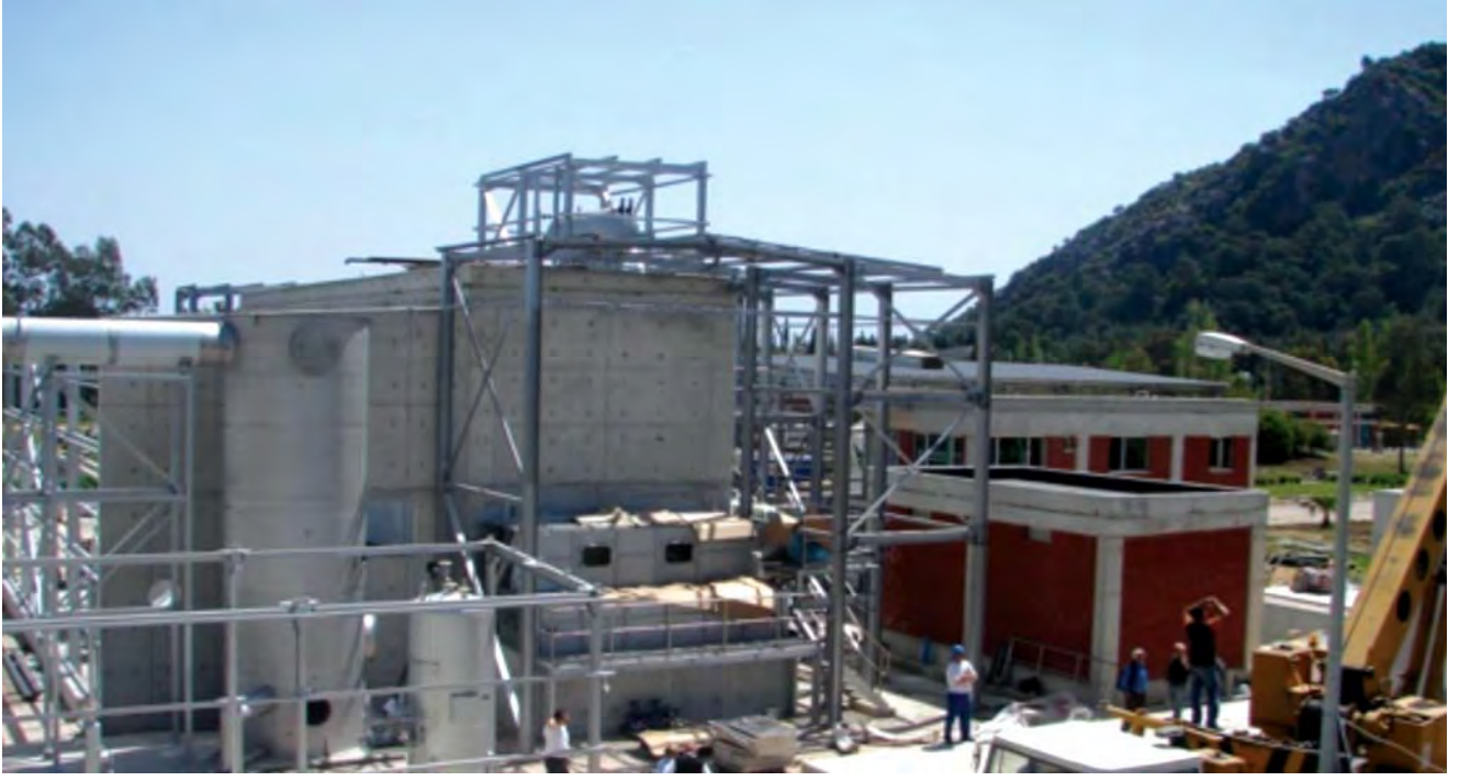
Arıtma Çamuru Termal Kurutma Tesisi İnşaat İşleri
