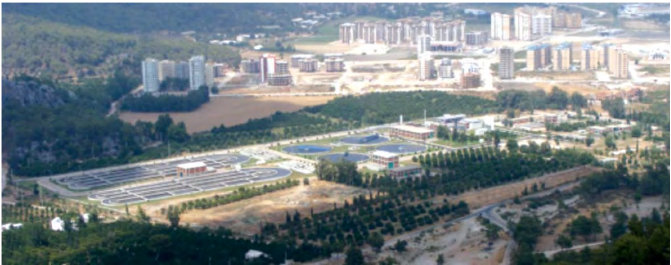
Hurma İleri Biyolojik Atıksu Arıtma Tesisi Genel Görünüm
