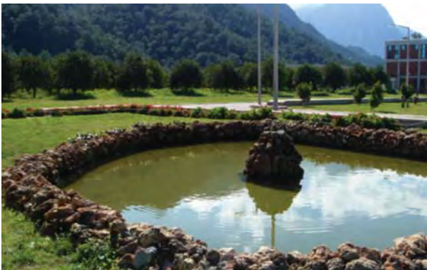
Hurma İleri Biyolojik Atıksu Arıtma Tesisi / Deşarj Suyu İle Beslenen Balık Havuzu
