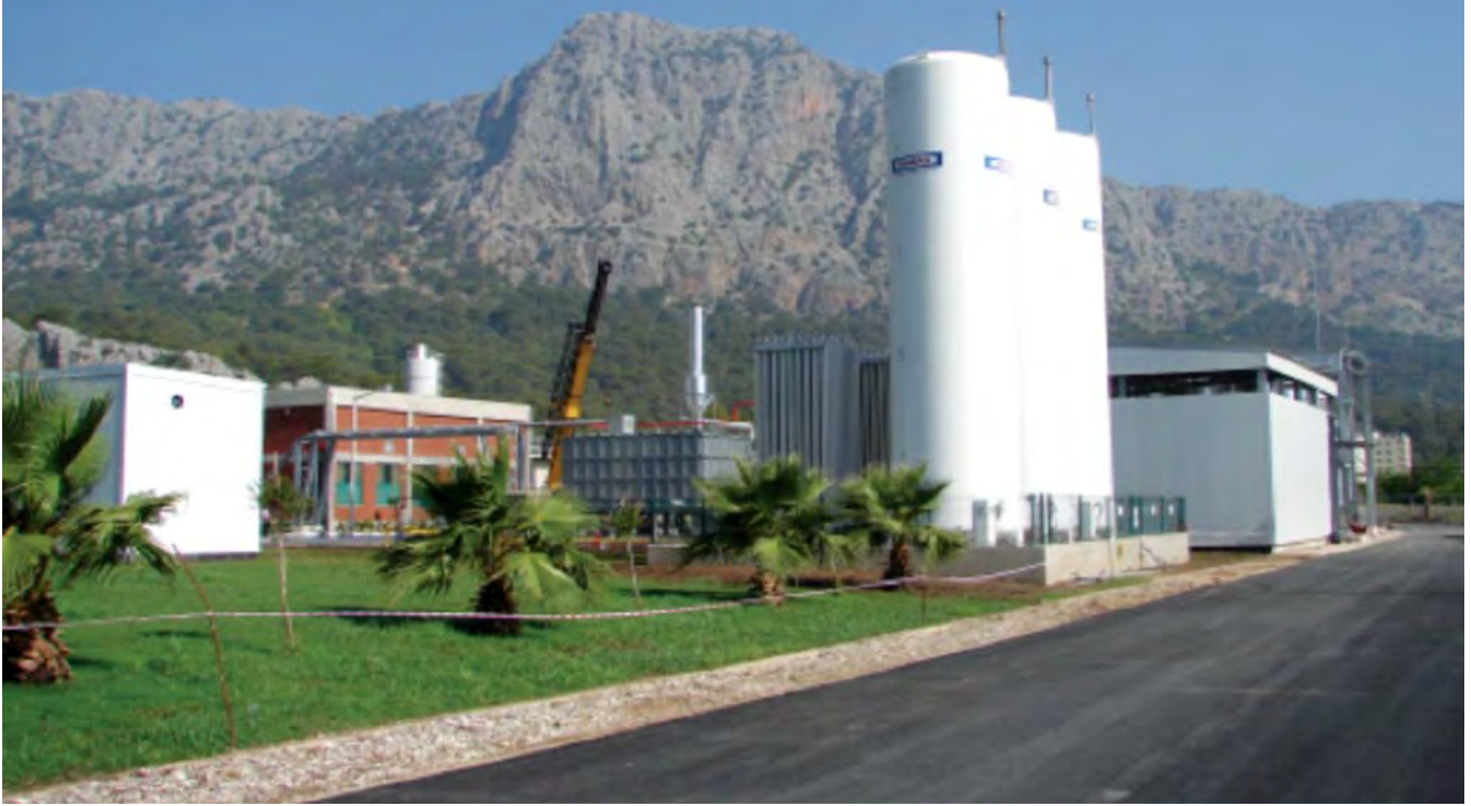
Arıtma Çamuru Termal Kurutma ve Ko-Jenerasyon Tesisi Genel Görünüm
