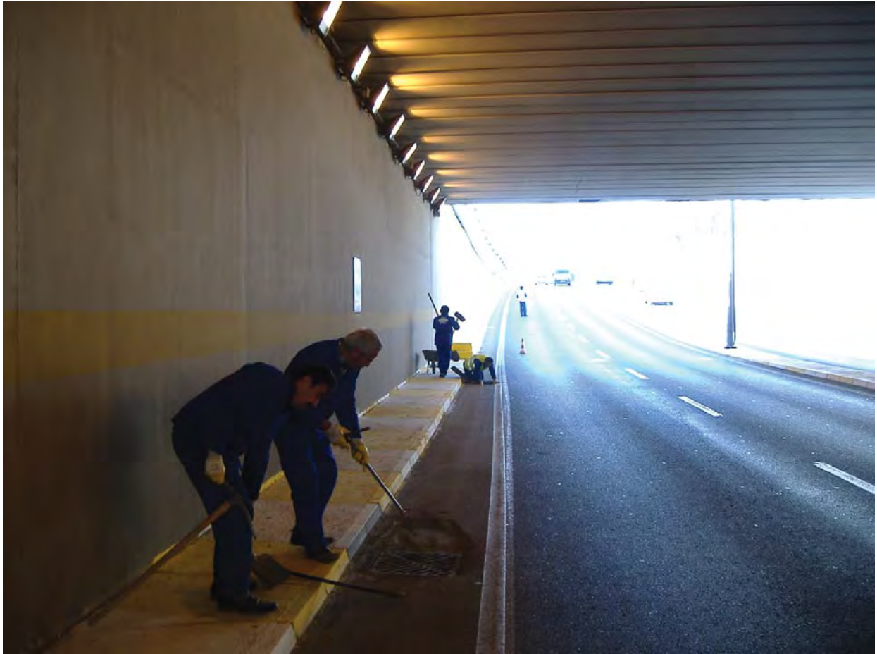
ALT GEÇİT IZGARALI KANAL TEMİZLİĞİ
