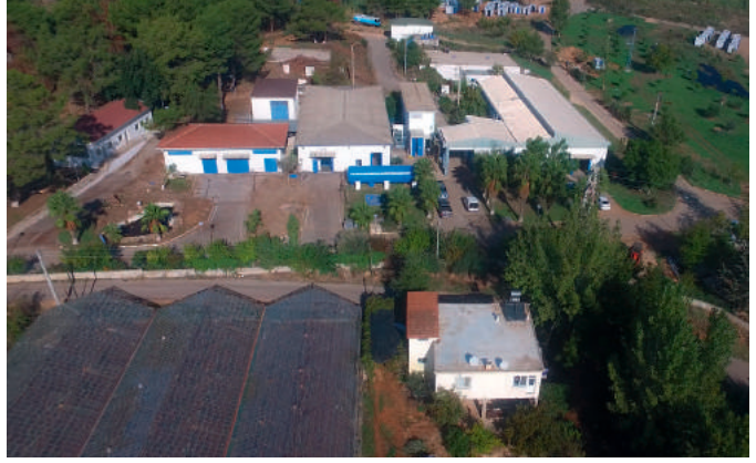
Duraliler Pompa İstasyonu
