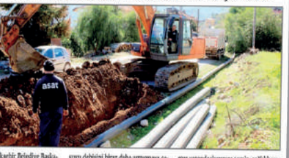
Yapılan çalışma, Büyükşehir Belediyesi ASAT Genel Müdürlüğü tarafından gerçekleştiriliyor. Adrasan Mahallesi'nde su arzı için su hattı hattı çalışmaları kesintisiz olarak karşılama amacıyla, sahil mevkiinden Deniz Yolu caddesine kadar olan bölgede 1200 metre içme suyu hattı yapıyor.
