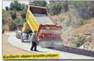
Büyükşehir ekipleri asfalta koyuyor.
