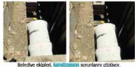
Belediye ekipleri, kanalizasyon sorunlarını çözüyor.
