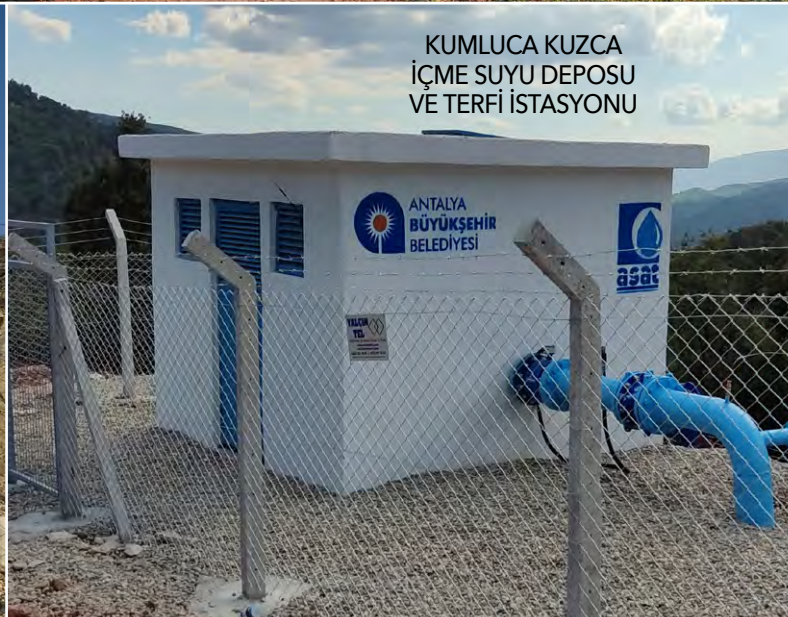
MANAVGAT DEĞİRMENLİ 200 m³ İÇME SUYU DEPOSU
