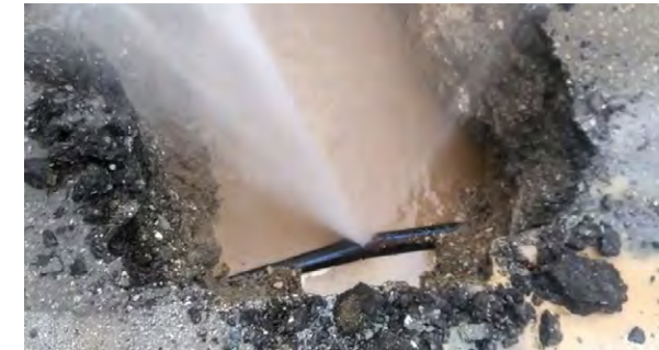
Kepez Yeni Doğan Mahallesi 3069 Sokak Ø 110 mm HDPE Boru Yarık
