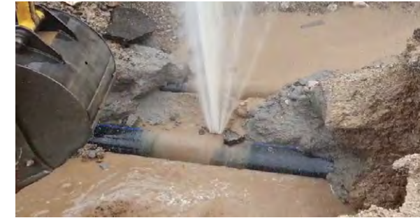
Döşemealtı Belediyesi Yiğmalar Mah. İnönü Cad. Ø 400 mm HDPE boru Yarık
